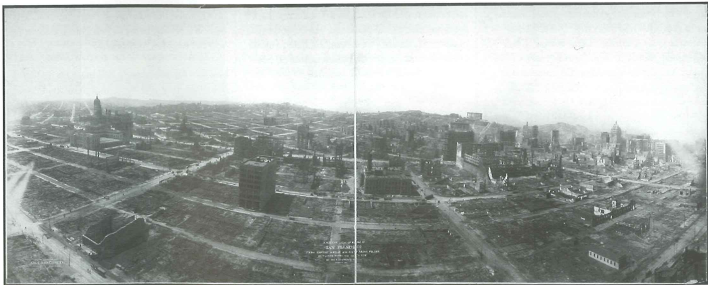
Panoramafoto 1, 5 mei 1906, gemaakt vanaf een hoogte van circa 180 meter. Formaat 49,8 x 119,4 cm. Het hoge gebouw met het ui-vormige dak aan de linkerkant van de foto is de City Hall. De witte streep over het midden is het doek waarop de afdrukken ooit zijn geplakt. De opname is echter in één geheel gemaakt. Geheel links op de foto is onscherp het uiteinde te zien van een van de stabiliserende armen.
